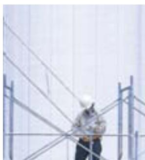
3 もう一方の先づけ手すり支柱に二段手すりの取り付け
