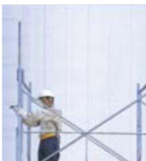
1 建枠上端に先づけ手すり支柱の差し込み、取り付け
