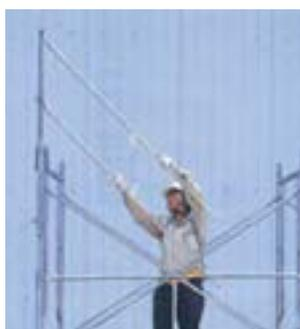
2 先づけ手すり柱に、二段手すりの差し込み、取り付け
