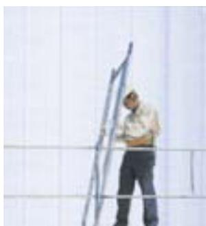
6 上段の建枠、ブレースの組み立て
