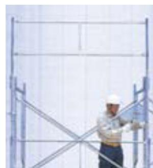
4 手すりユニットを持ち上げ、建枠上端に差し込み取り付け
