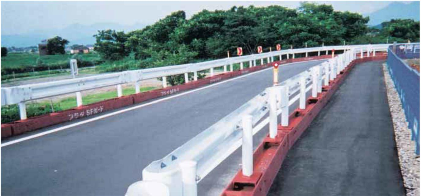
歩道工事、構台工事、道路面に沿った工事など通行の安全確保を重点とした、仮設用ガードレールです。
